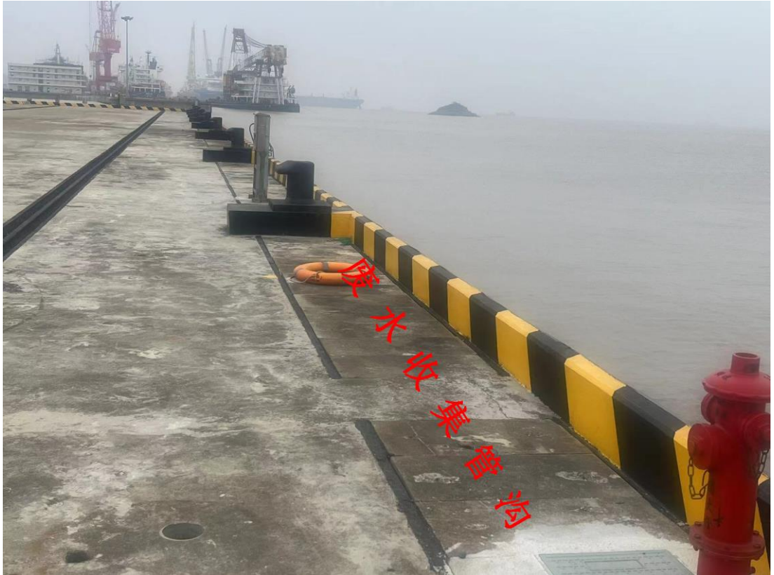
图7-2 废水收集管沟
