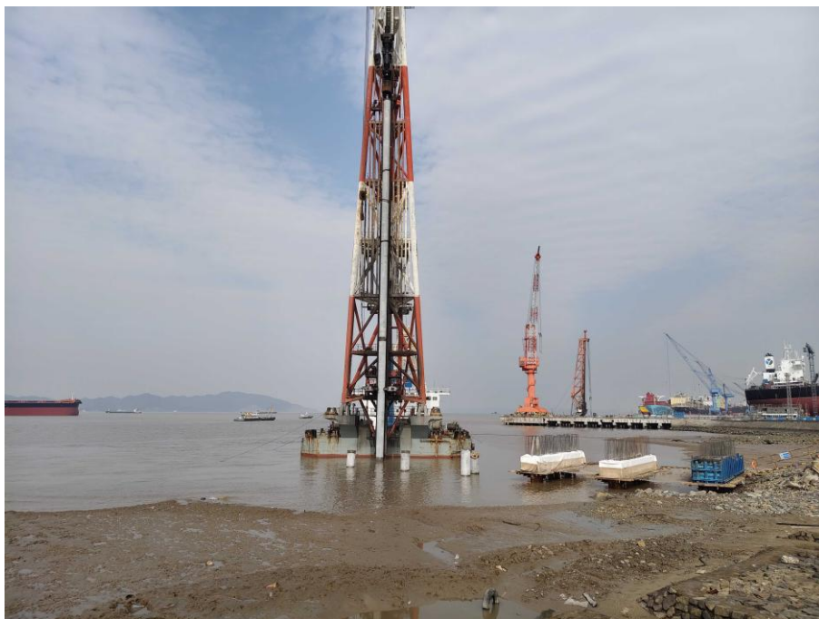
图 10.1-1 PHC 管桩施工
