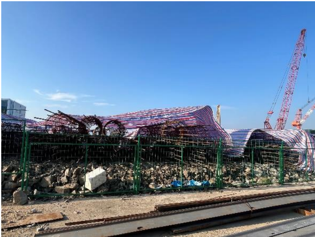
图 6.1-2 露天堆场加盖篷布
