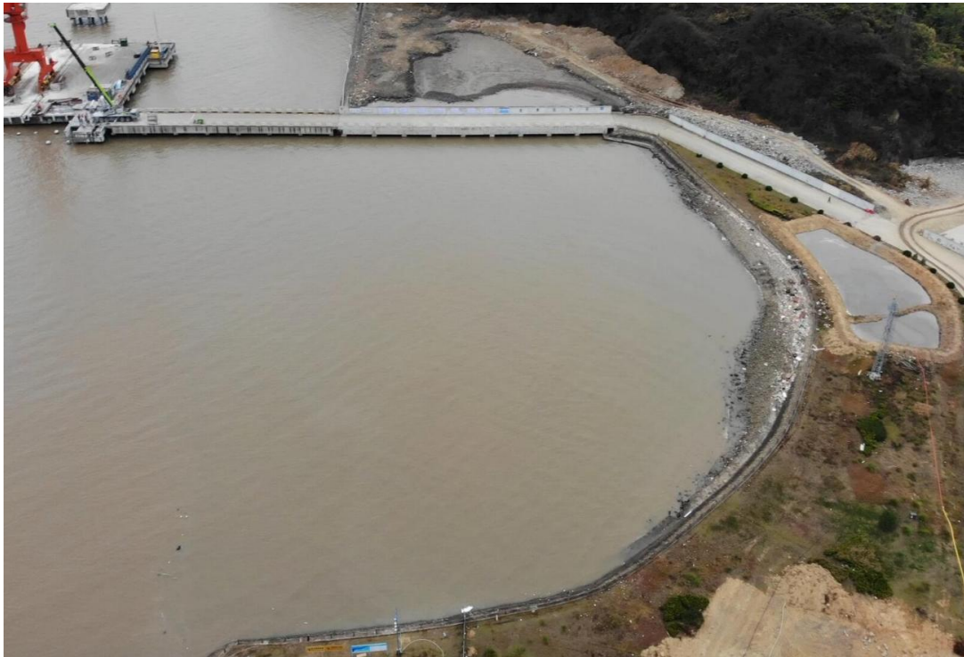
图 3-2 永亨外海塘现状
