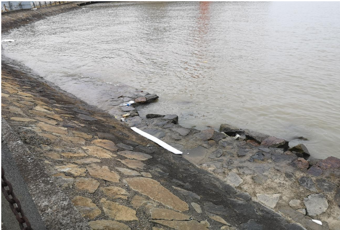
图 3-4 永亨外海塘迎海侧现状
