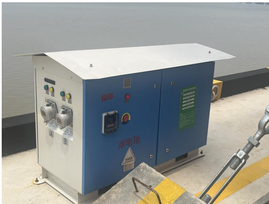
图7-6 码头岸电系统
