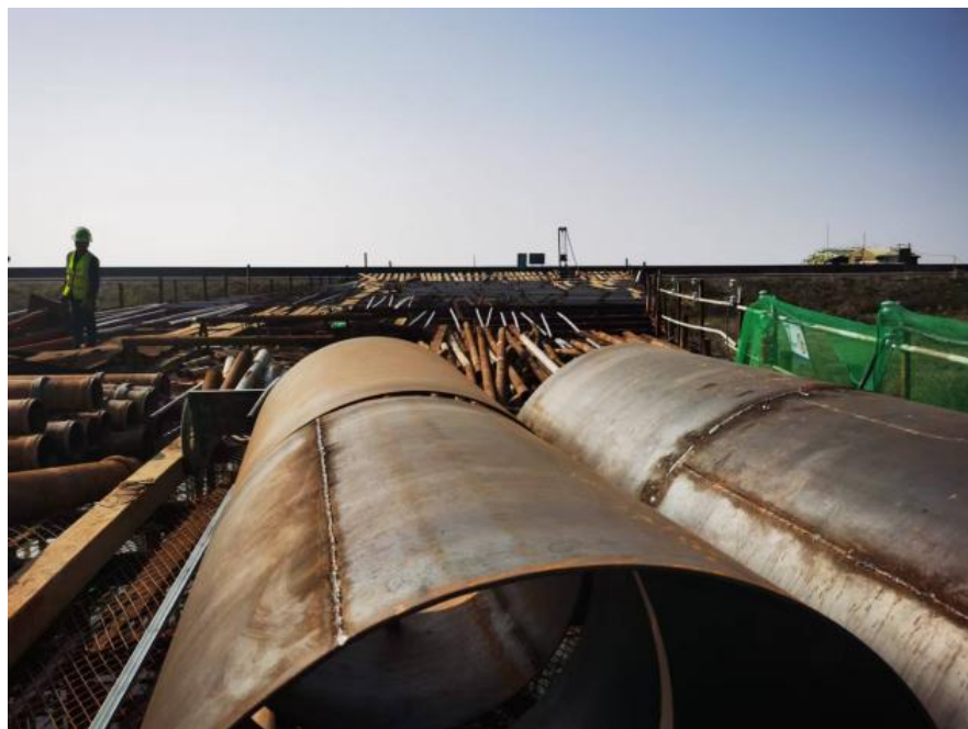
图7-3 灌注桩钢护筒
