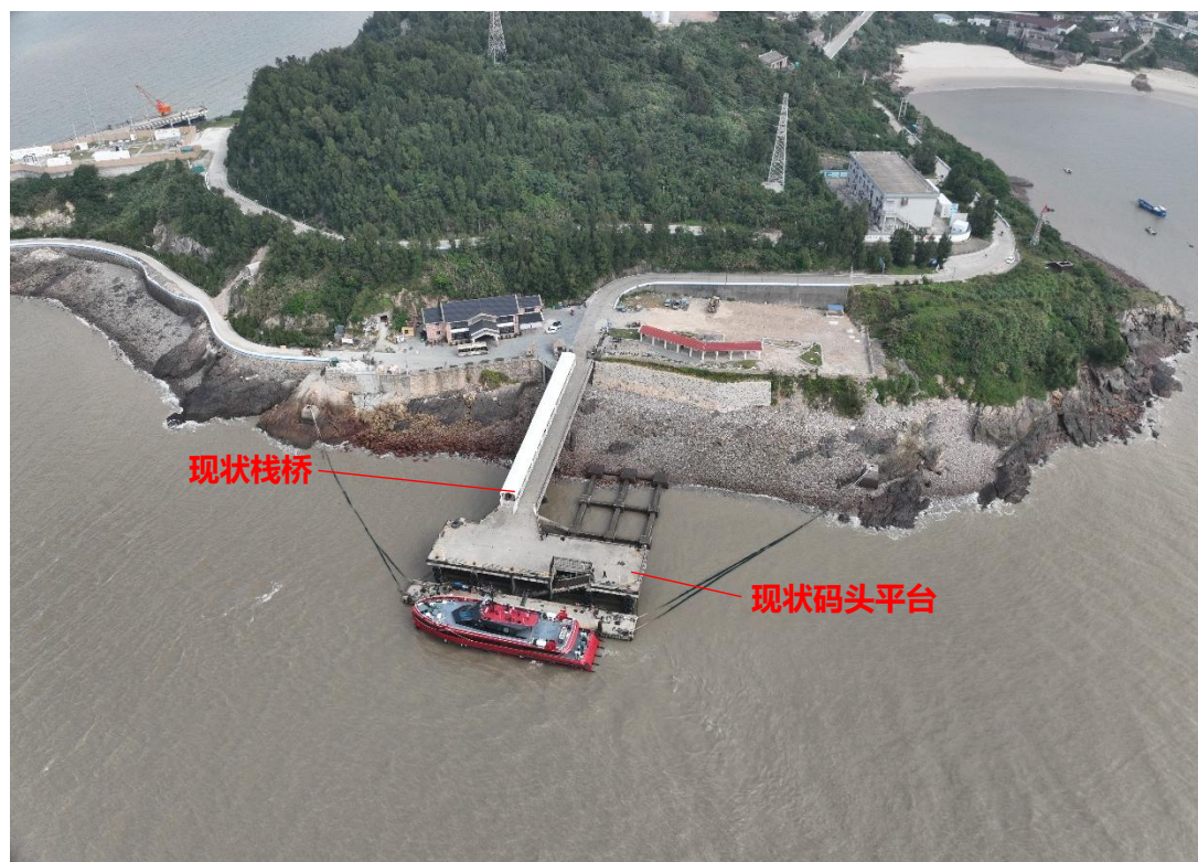
图 3.2-1 交通码头现状情况
