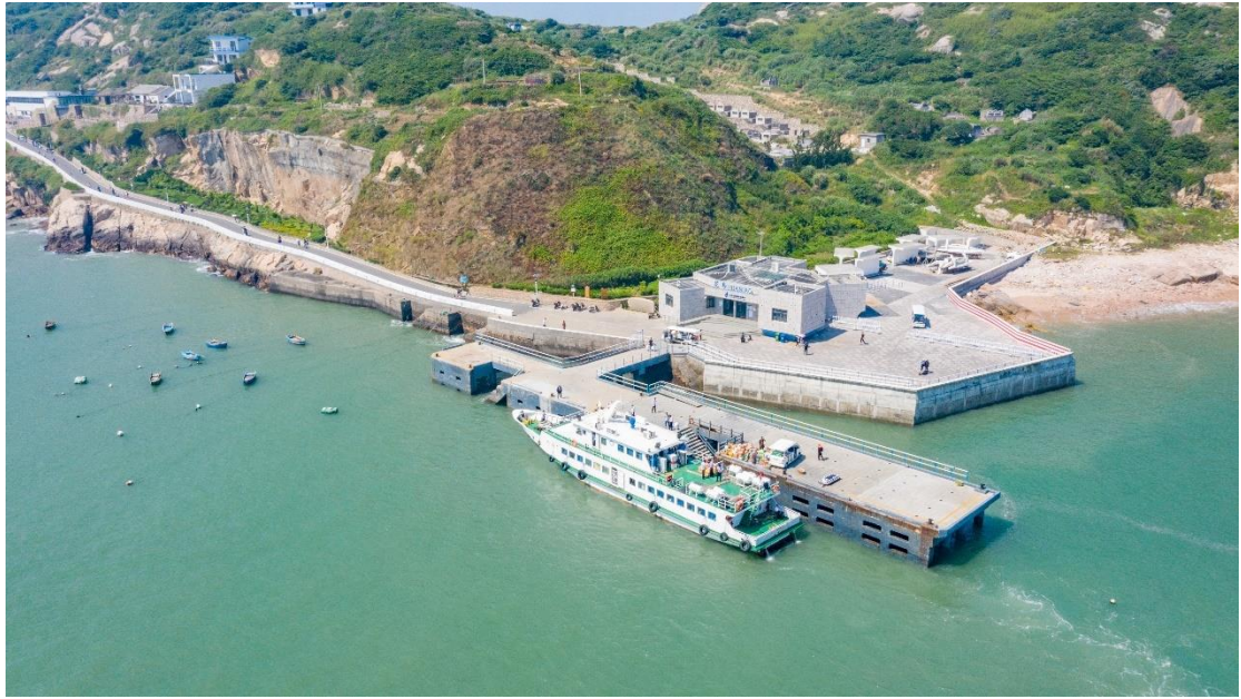
图 2 现状南岙客运码头（客运站拆除前）
