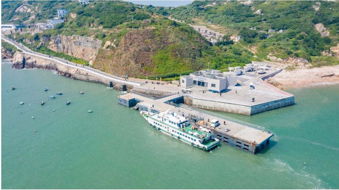
图 1.1-2 现状南岙客运码头（客运站拆除前）
