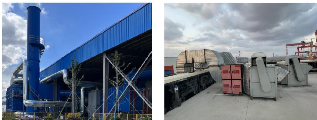
图 3.2-7 三级干式过滤+沸石转轮+RTO
